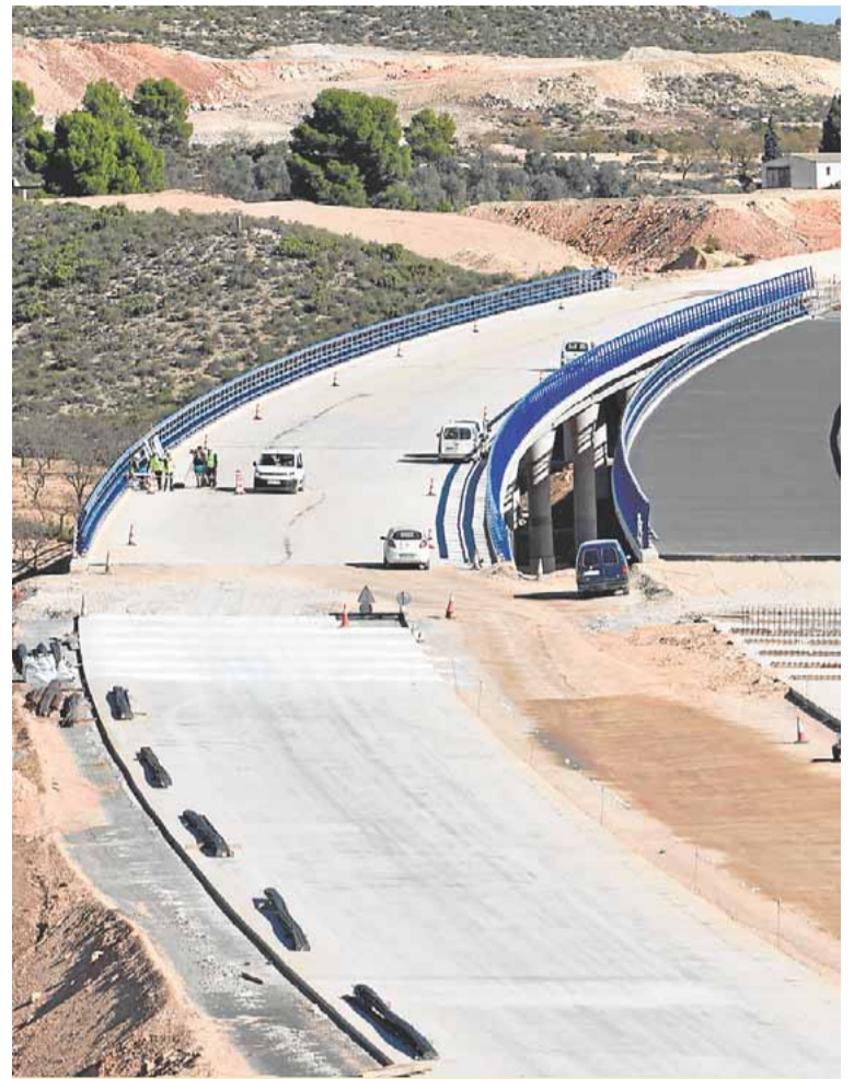
Construcción del último tramo de la Autovía del Altiplano. Javier Carrión
