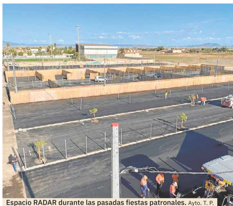
Obras para crear la red ciclable. Ayto. Torre Pacheco
