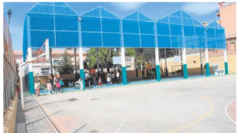
Nueva cubierta para las instalaciones del CEIP Santiago. Ayto. Totana
